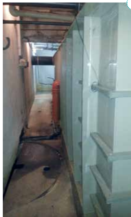
◆ ZBIORNIK WYRÓWNAWCZY WYKONANY NA MIEJSCU Z PP W TRAKCIE PIERWSZEGO ETAPU REMONTU
