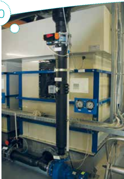
◆ PODBASENIE Z FILTRAMI CAPTURA
