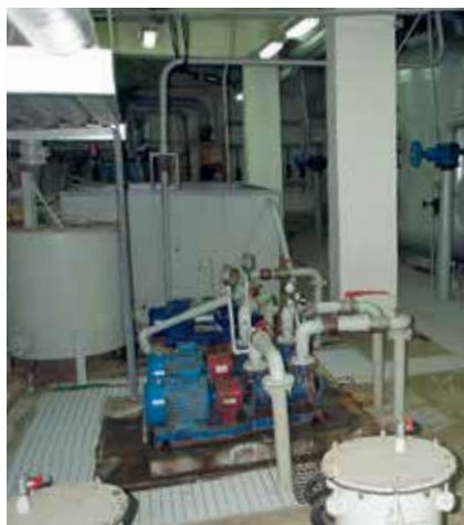
◆ STACJA OCZYSZCZANIA WODY PRZED REMONTEM
