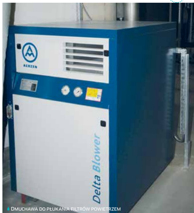
DMUCHAWA DO PŁUKANIA FILTRÓW POWIETRZEM
