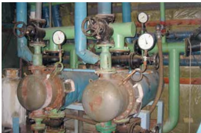
♦ WYMIENNIKI PRZED REMONTEM
