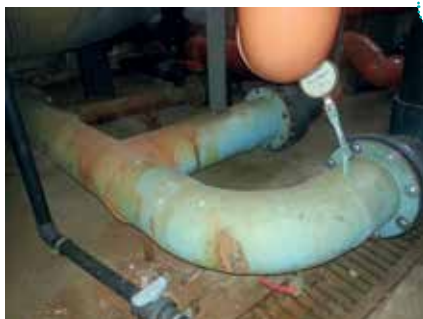
◆ WIDOCZNE SKORODOWANE ORUROWANIE STALOWE, WYMIENIONE W ETAPIE DRUGIM WRAZ Z ZABUDOWĄ POMPY TŁOCZĄCEJ
