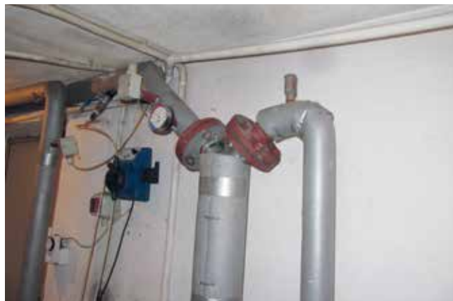
WYMIENNIK TYPU JAD PRZED WYMIANĄ
