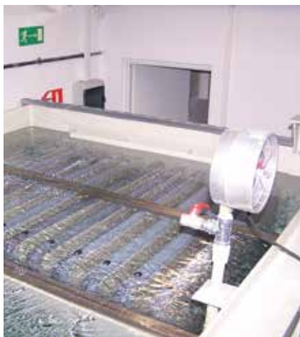
● FILTR PODCIŚNIENIOWY Z POMOCNICZĄ WARSTWĄ FILTRACYJNĄ
