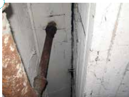
◆ WIDOCZNE SKORODOWANE ORUROWANIE STALOWE, WYMIENIONE W ETAPIE DRUGIM WRAZ Z ZABUDOWĄ POMPY TŁOCZĄCEJ
