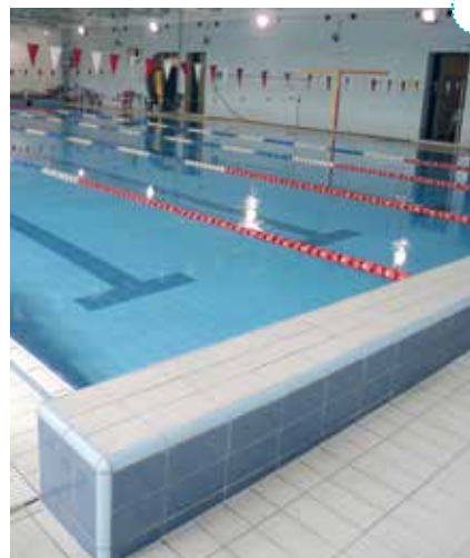
WYOBLENIA NA MURKACH ORAZ POCHWYTY KRAWĘDZIOWE WZDŁUŻ DŁUGICH ŚCIAN BASENU W ODZNACZAJĄCYCH SIĘ KOLORACH ZA POMOCĄ PORCELANOWYCH ĆWIERĆWAŁKÓW I POCHWYTÓW KRAWĘDZIOWYCH SERAPOOL
