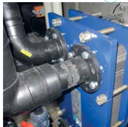
WYMIENNIK PŁYTOWY Z RURAMI PEHD
