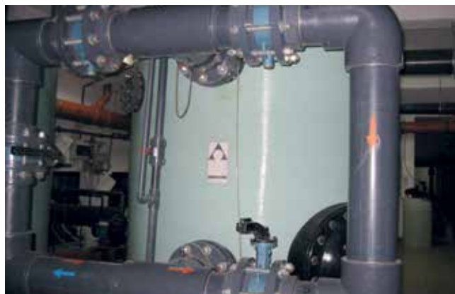
♦ ZAWORY ZBYT WYSOKO – KŁOPOTY Z OBSŁUGĄ
