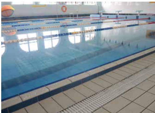
◆ ZDJĘCIE PO 3 ETAPACH REMONTU I PRZED REMONTEM – NA ZDJĘCIU PO PRAWIE WIDOCZNE BRAKI W SPOINOWANIU, ZŁY STAN PŁYTEK POSADZKOWYCH I USZKODZONE USZCZELNIENIE DYLATACYJNE
