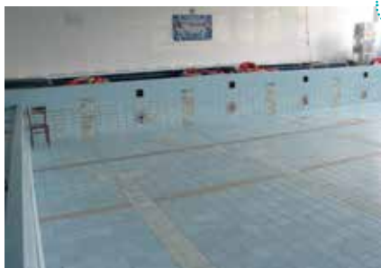
WIDOCZNE BRAKI W CERAMICE BASENOWEJ, RÓŻNE ODCIENIE PŁYTEK SPOWODOWANE ZUŻYCIENIAMI PO SAMOISTNYM ODPADANIU PŁYTEK PO COROCZNYM SPUSZCZANIU WODY
