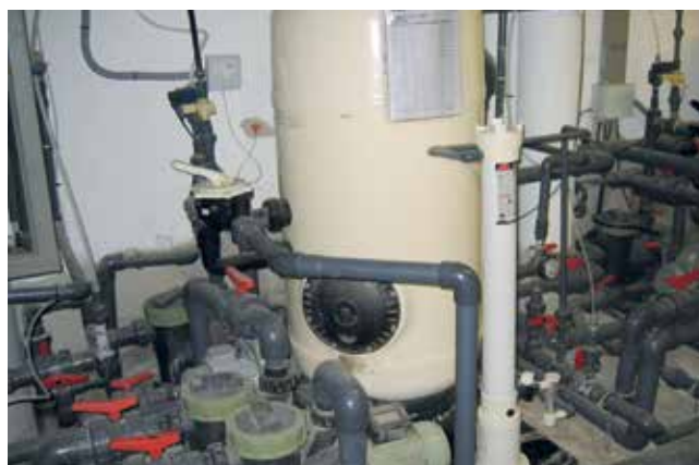
◆ FILTR Z ZAWOREM SZESĆCIODROGOWYM - TRUDNOŚCI W OBSŁUDZE - BRAK MIEJSCA
