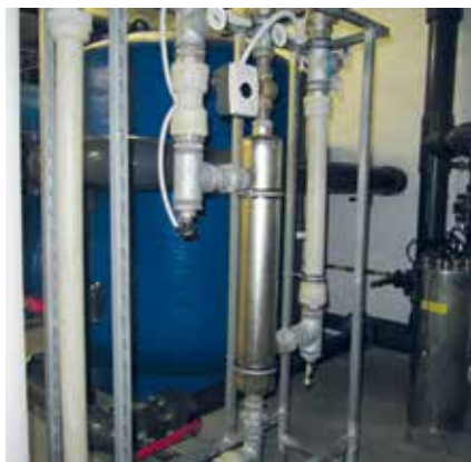
WYMIENNIK Z KSZTAŁTKAMI OCYNKOWANYMI
