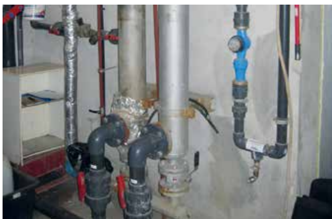
WYMIENNIK Z RURAMI PVC – MOŻE WYSTĄPIĆ PROBLEM, POWINNY BYĆ CPVC
